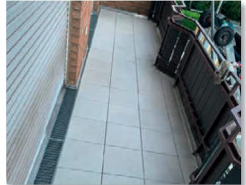
dig um Staunässe zu vermeiden. Erst wenn Unterkonstruktion und Estrich in Ordnung sind, kann der Neuaufbau beginnen und die eigentliche Abdichtung erfolgen. Nach der Grundierung werden zuerst die Anschlüsse an Wänden und Türen abgedichtet, anschließend die Fläche. Die eigentliche Abdichtung erfolgt heutzutage überwiegend mit Flüssigkunststoff. Alternativ können auch Bitumen- oder Kunststoffbahnen zum Einsatz kommen. Ein neuer Bo-
